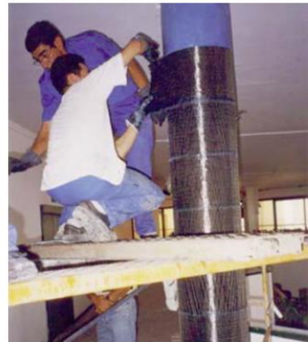
: Refuerzo de soportes con CFRC ( A. de Diego, A. Arteaga, Ref. 30 )
