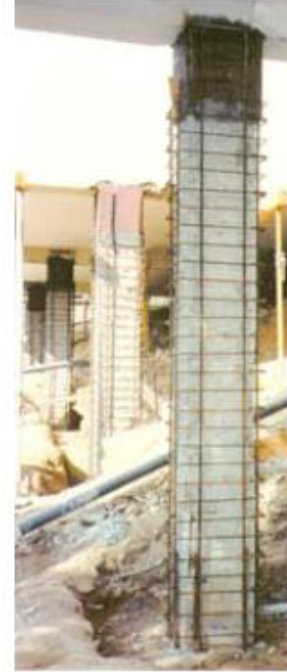
Refuerzo de soportes mediante recrecido de h.a. (F. Regalado, Ref.46)
