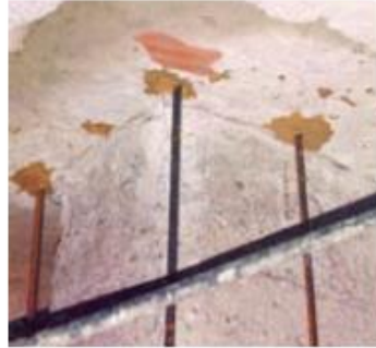
Refuerzo de soportes mediante recrecido de h.a. (F. Regalado, Ref.46)
