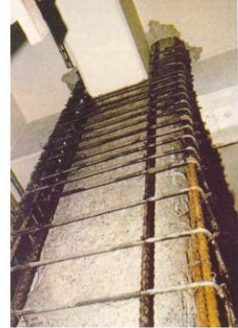
Refuerzo de soportes mediante recrecido de h.a. (F. Regalado, Ref.46)
