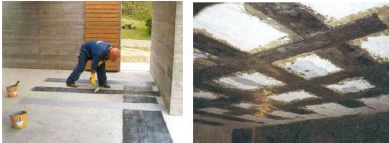
Refuerzo de forjados mediante tejido de fibra de carbono (Sika – Freyssinet)
