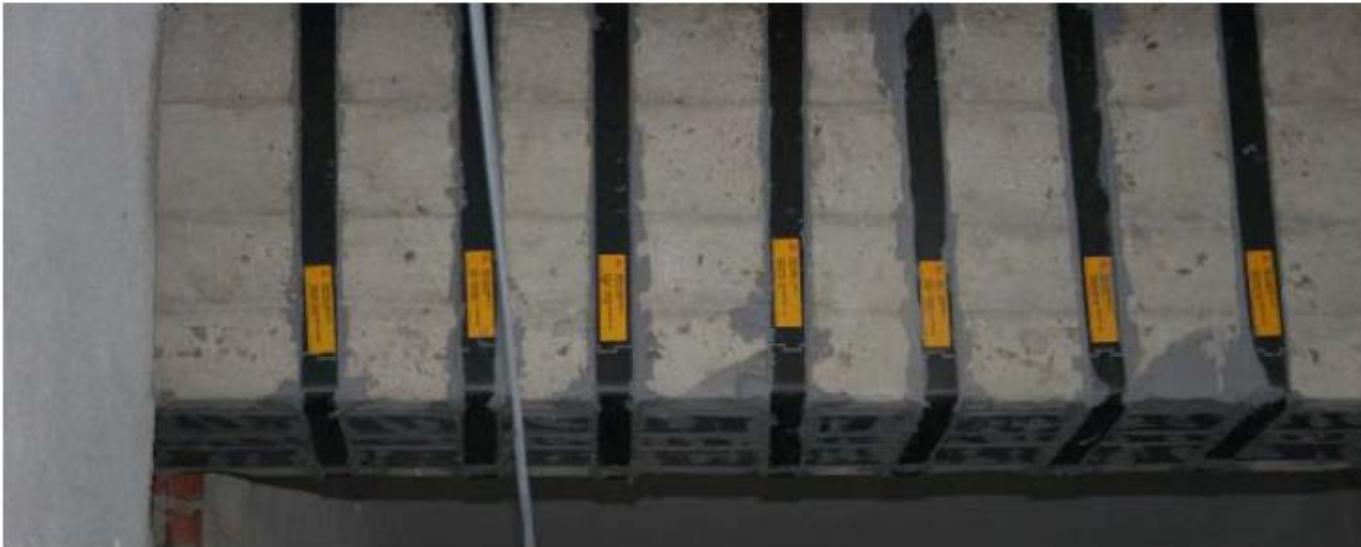
Refuerzo de vigas a cortante mediante fibra de carbono
