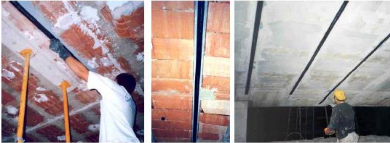
Refuerzo de forjados mediante laminados de fibra de carbono ( www.sika.es )
