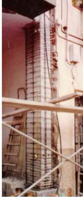
Refuerzo de soportes mediante recrecido de h.a. (F. Regalado, Ref.46)
