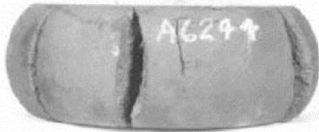
Grietas de Forjado
