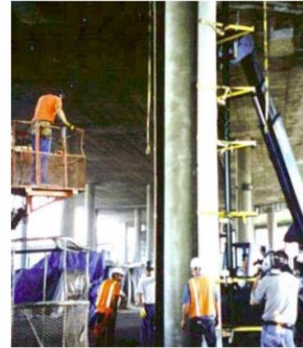
: Refuerzo de soportes con CFRC ( A. de Diego, A. Arteaga, Ref. 30 )
