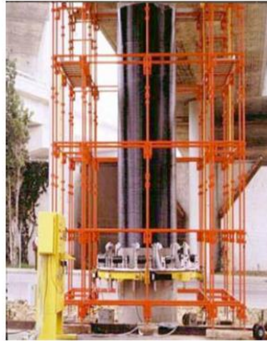
: Refuerzo de soportes con CFRC ( A. de Diego, A. Arteaga, Ref. 30 )
